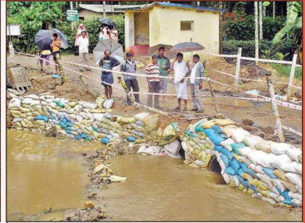
பந்தலூர்-பாட்டவயல் இடையே தற்காலிகமாக அமைக்கப்பட்ட பாலம் சரிபும் நிலையில் உள்ள காட்சி.
